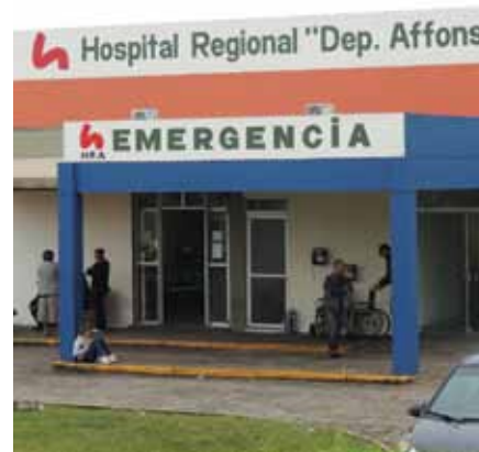
Fachada do HRA
